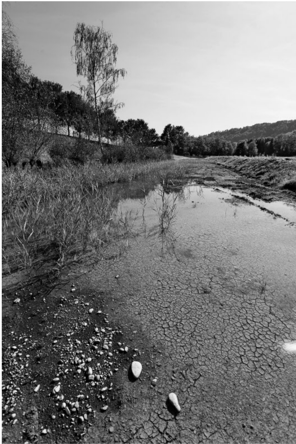
Renaturierungsarbeiten: Der Humus soll bald abtransportiert werden.
